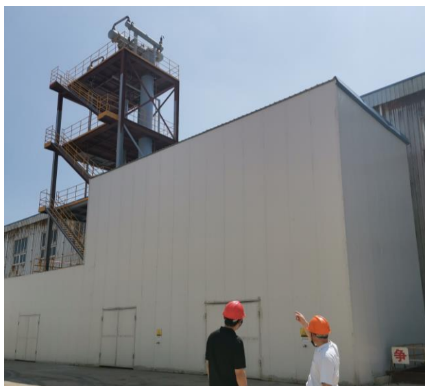
图 2.1.1-1 拟建项目中试车间及精馏塔、加氢装置建设情况
