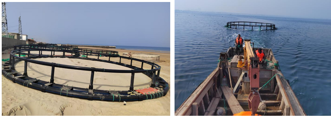
图 2-9 网箱框架组装、拖运示意图
