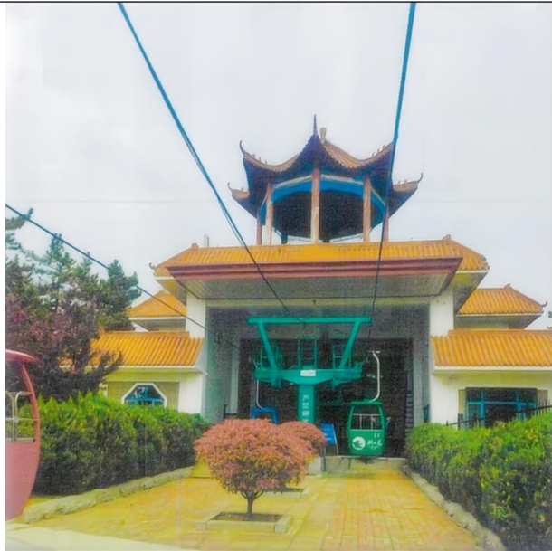
项目上站现状
