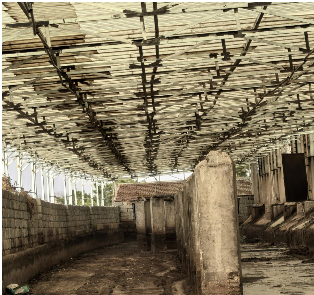
图 2.1-5 (b) 蓄粪池现状
