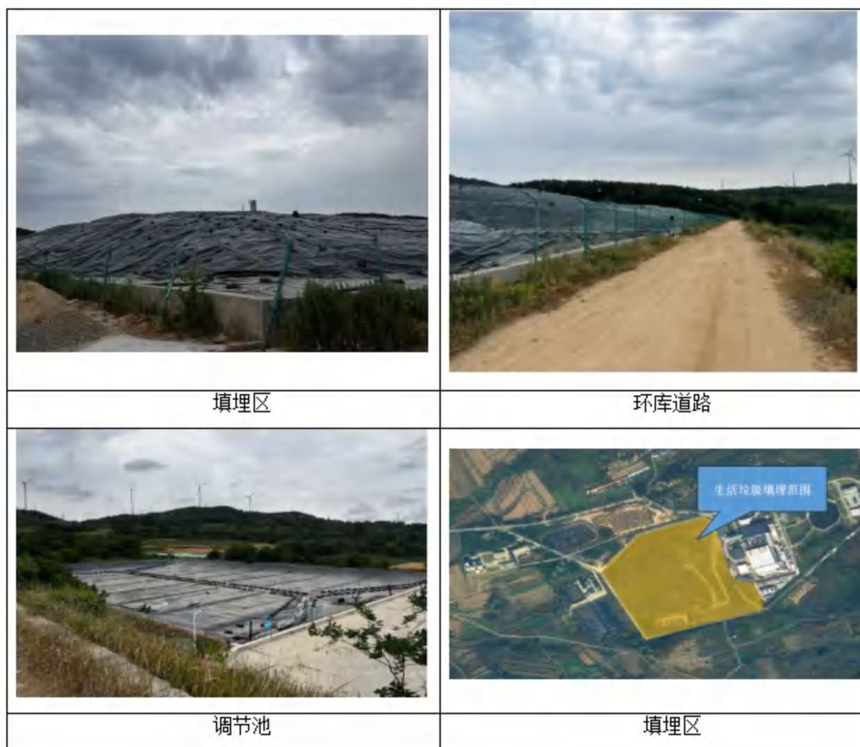
图 2.2-8 一期填埋区现场照片
