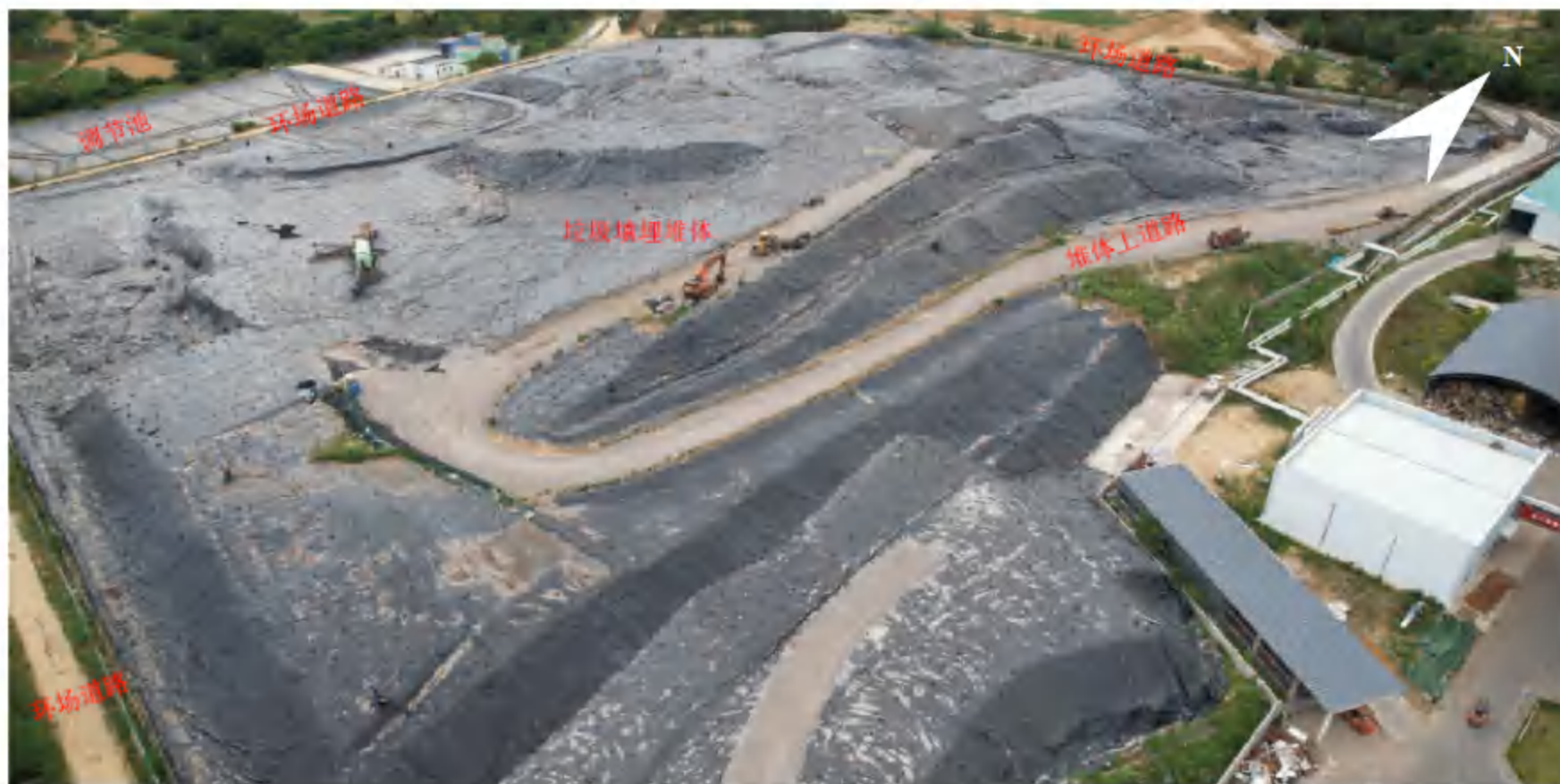
图 2.2-10 一期填埋区航拍照片
