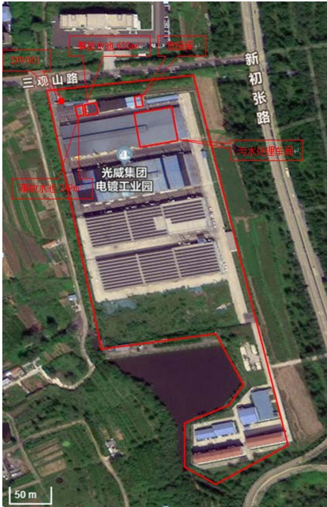
图2.10-1 威海光威电镀工业园现状图
