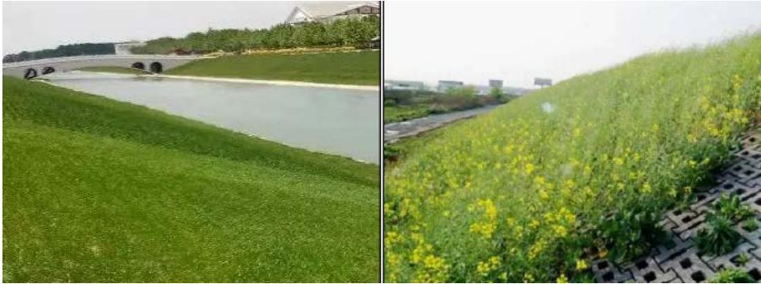
图 16 植草护坡+植草砖护坡效果示意图
