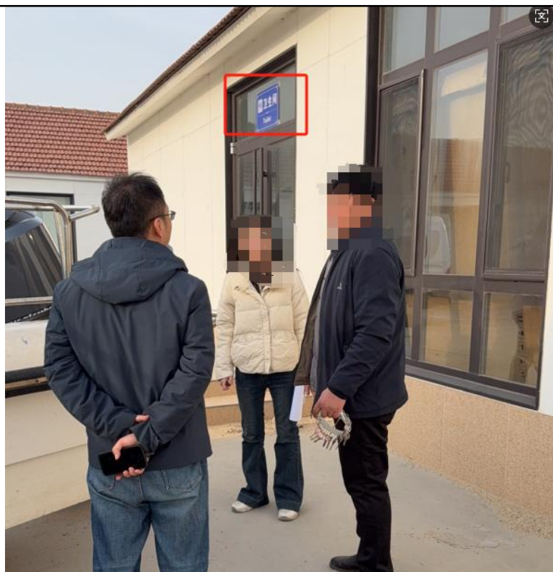
图 5.2-1a 陆域场所环保设施现状（卫生间）
