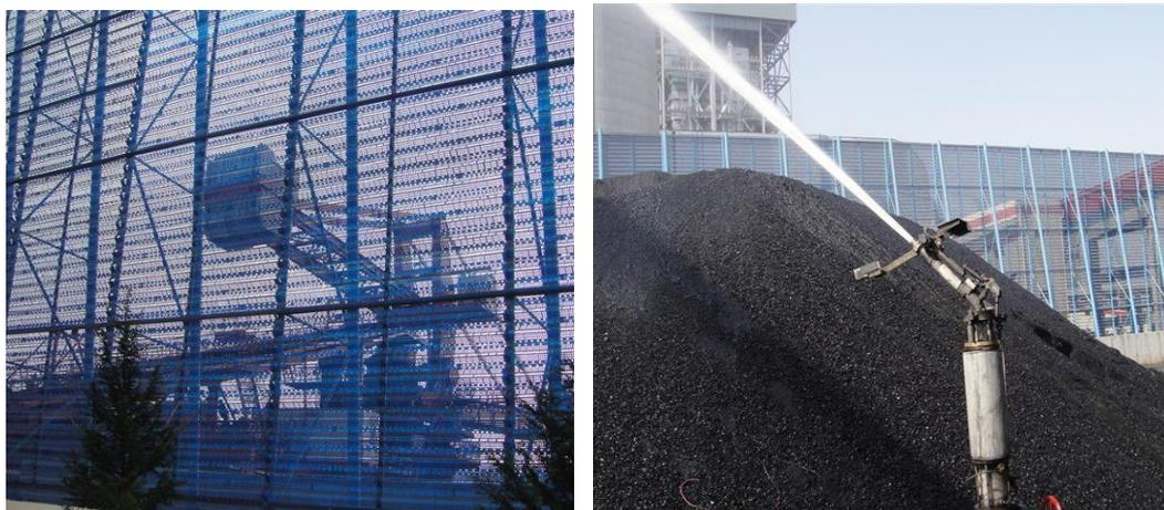
图 3.1-6 煤场防风抑尘网及喷淋系统
