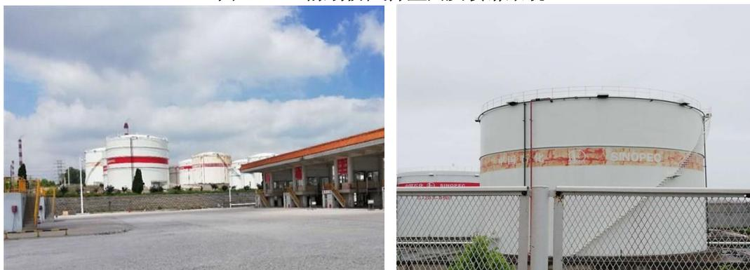
图 3.1-7 油品罐区浮顶罐
