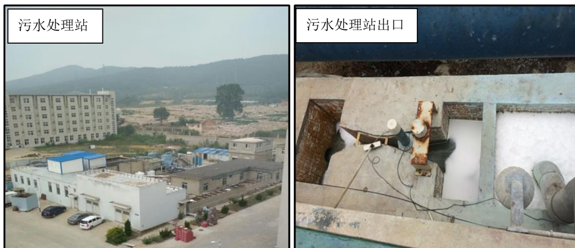
图 3.5-1 汇钜工业厂内污水处理站
