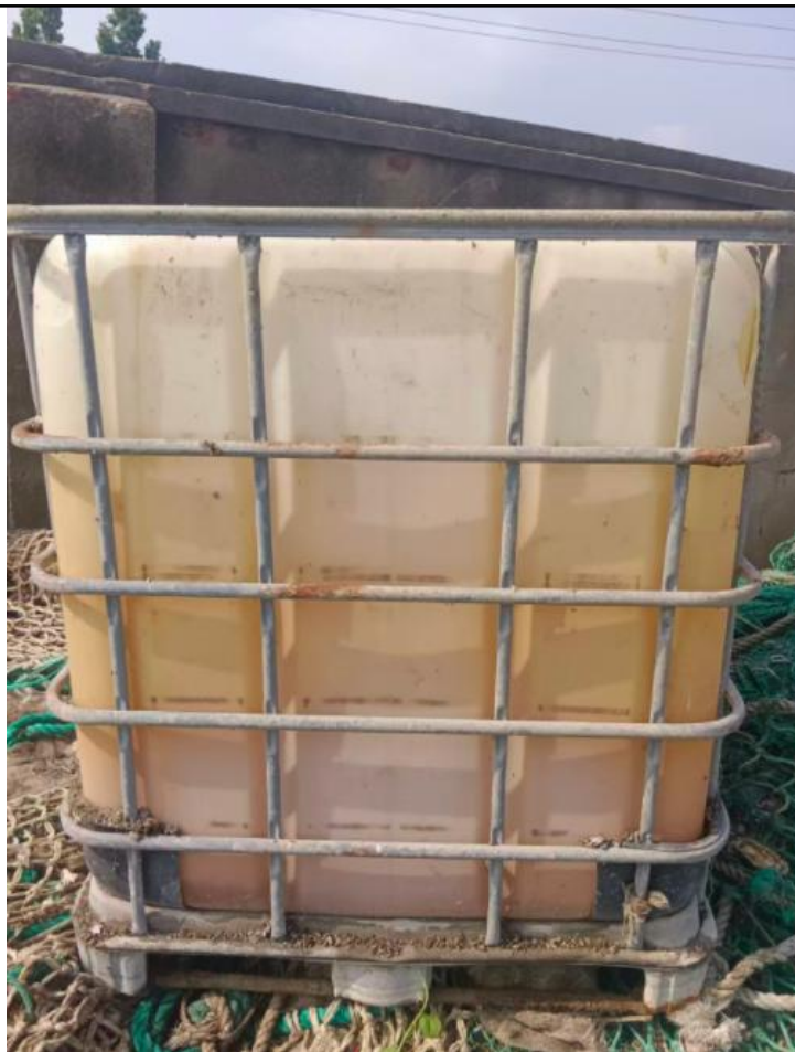
图 5.2-1c 陆域场所环保设施现状（含油污水收集桶）
